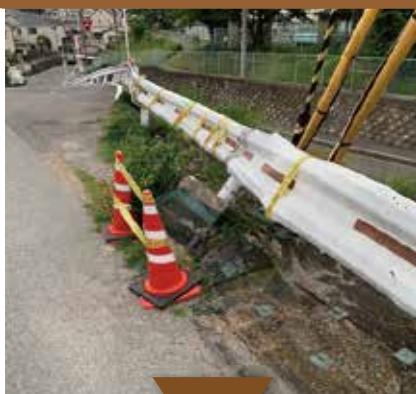
村野本町ガードレール補修工事完了
